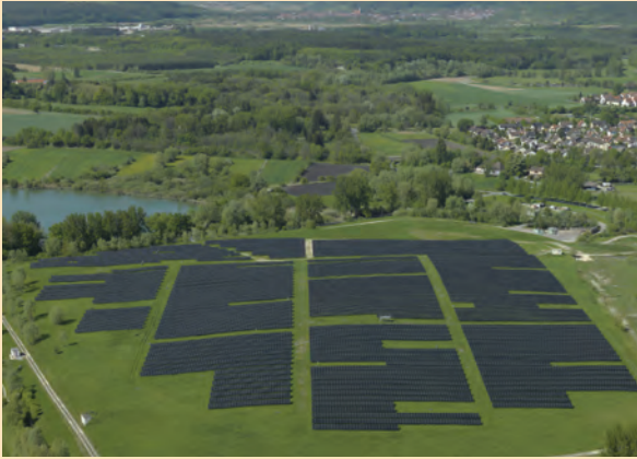
Solarpark Rickelshausen: 2,2 MW Leistung produzieren 2,5 Mio. kWh sauberen Strom
