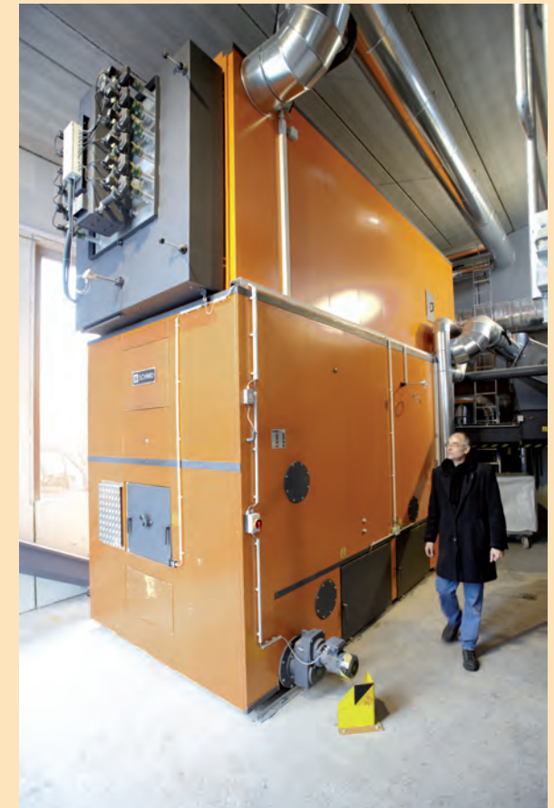
Hackschnitzelkessel in Randegg
