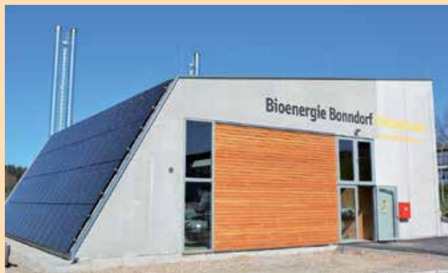
Heizzentrale im Nahwärmenetz Bonndorf
