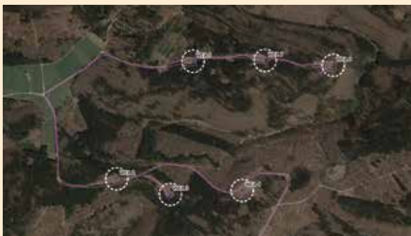
Windpark Länge, rd. 30 MW
