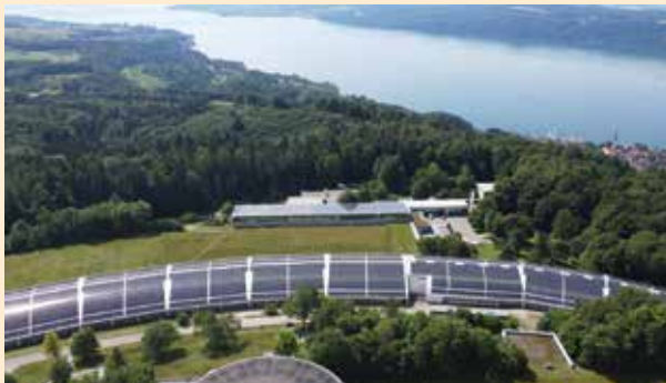
PV-Dachanlage Bodenseewasserversorgung, Sipplingen, 1,4 MW
