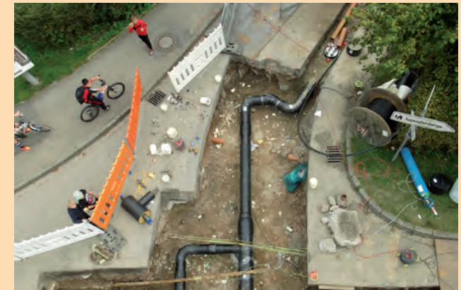
Verlegung der Rohrleitungen | Wärmenetz Bonndorf
