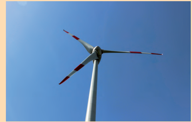
Windkraftanlage St. Georgen
